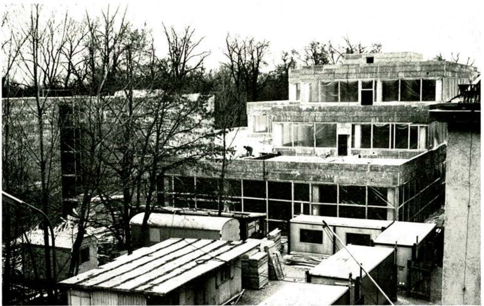
Neubau der Prähistorischen Staatssammlung, München 22, Lerchenfeldstraße, Stand März 1974. Oben Ansicht vom Englischen Garten mit Eingangshalle und Verwaltungsbau, rechts Ausstellungspavillons; unten Ansicht von SO, links Ausstellungspavillons, Mitte Wechselausstellung, rechts Verwaltung.
